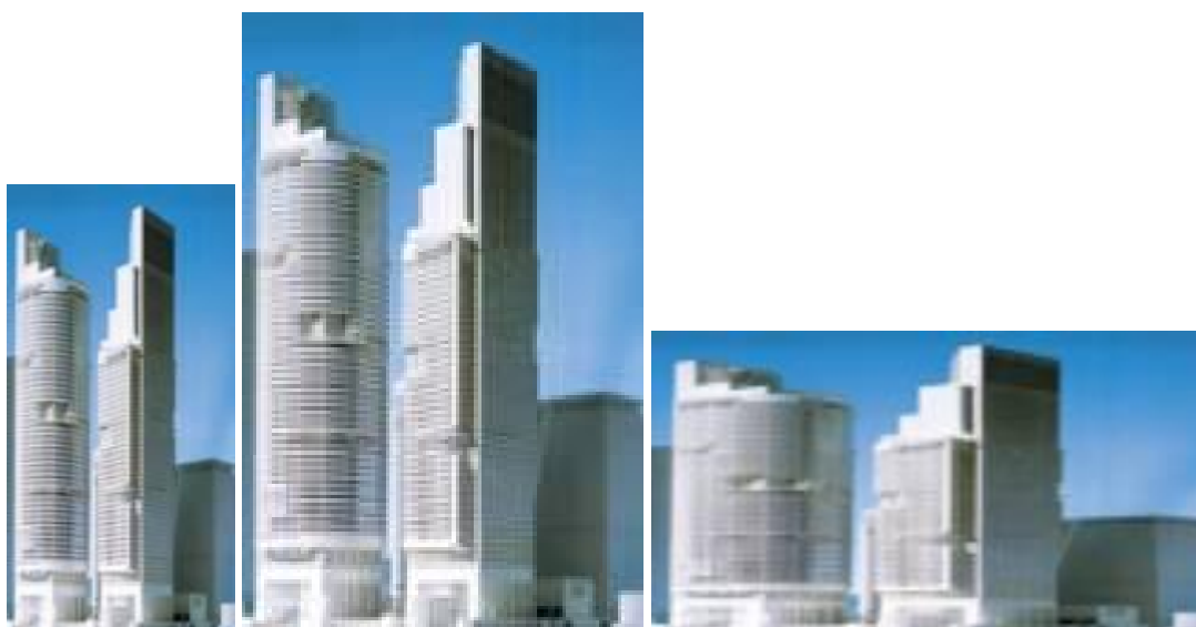
Рис. 1. Пример изменения формы здания с целью оптимизации теплоэнергетического воздействия климата на его тепловой баланс в зависимости от характерного периода года
